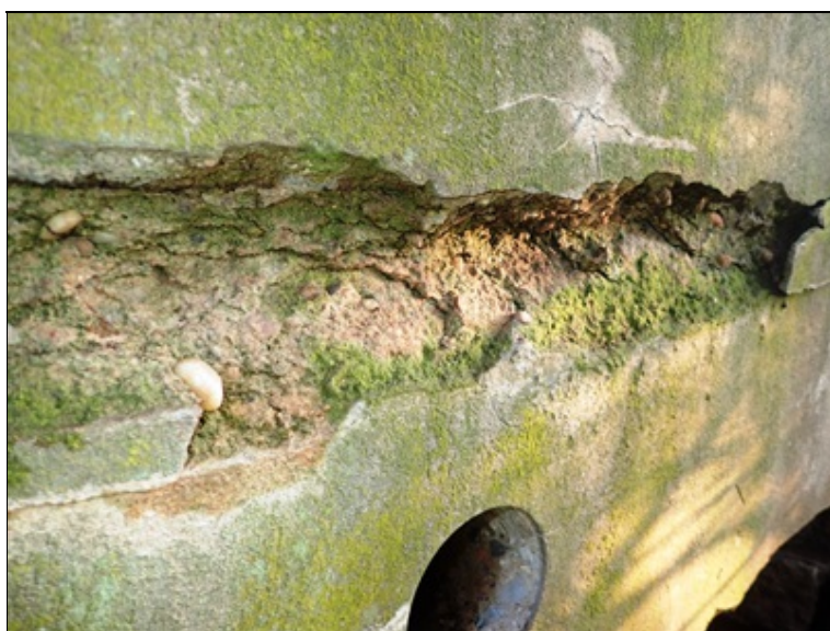
L portál, detail trhliny mezi NK a čelní zdí, mrazový rozpad betonu do hl. cca 5 cm.
